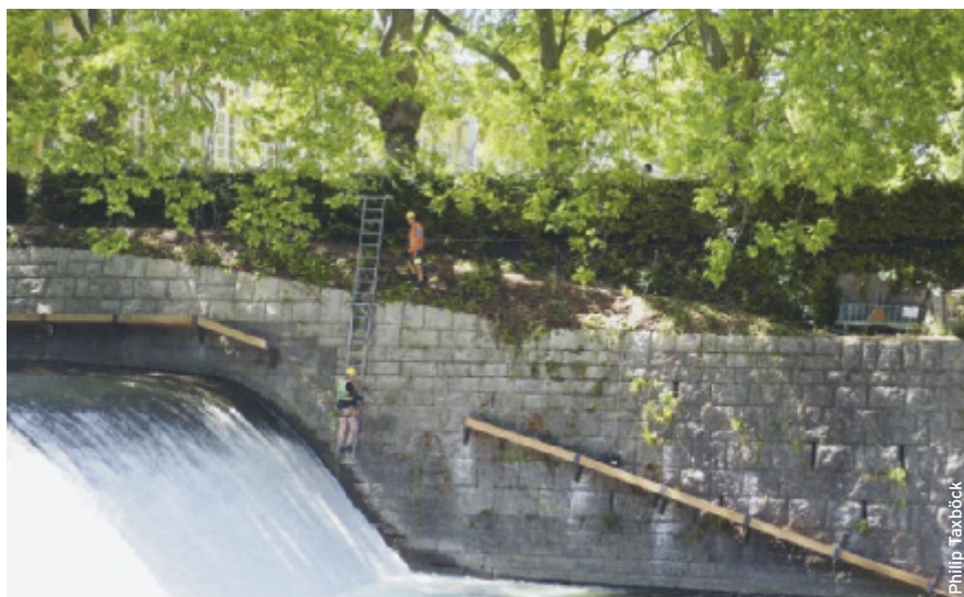
Montage der Biberrampe beim Zürcher Sihlhölzli.
